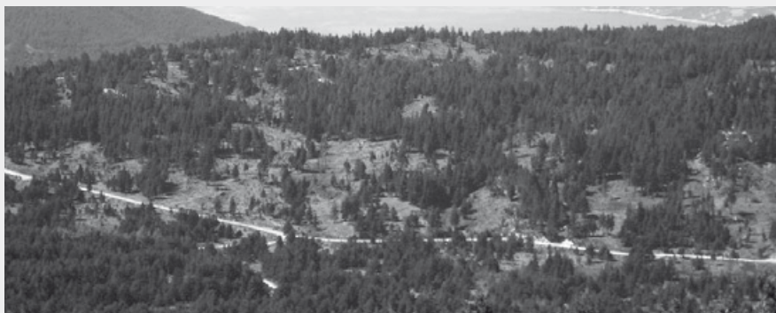
Εικ. 3: Από τη θέση «Κούρασμα» της Ρητίνης άποψη της Λίμνης Πολυφύτου και στο βάθος η Γέφυρα
